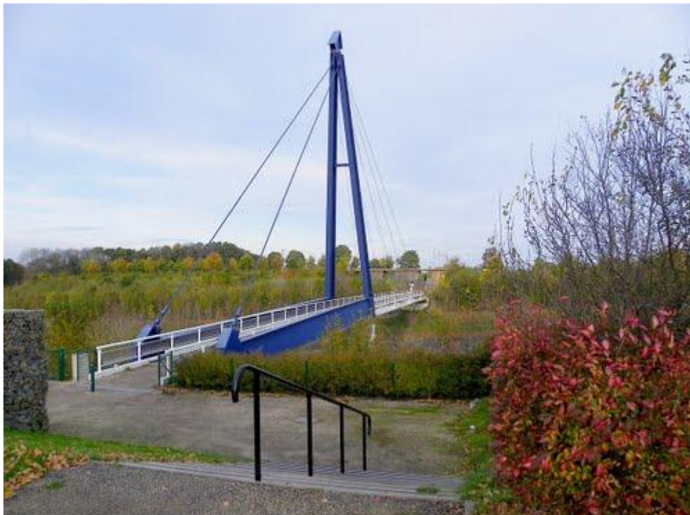
Passerelle sur l'A84
