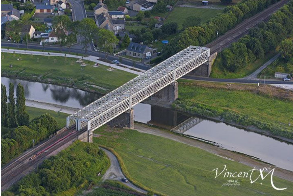
Pont de chemin de fer de Pontaubault
