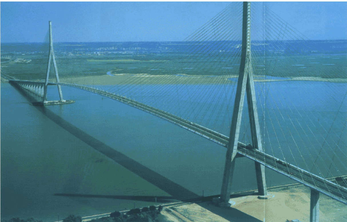
Pont de Normandie
