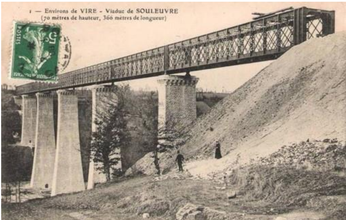
Viaduc de la Soulevre
