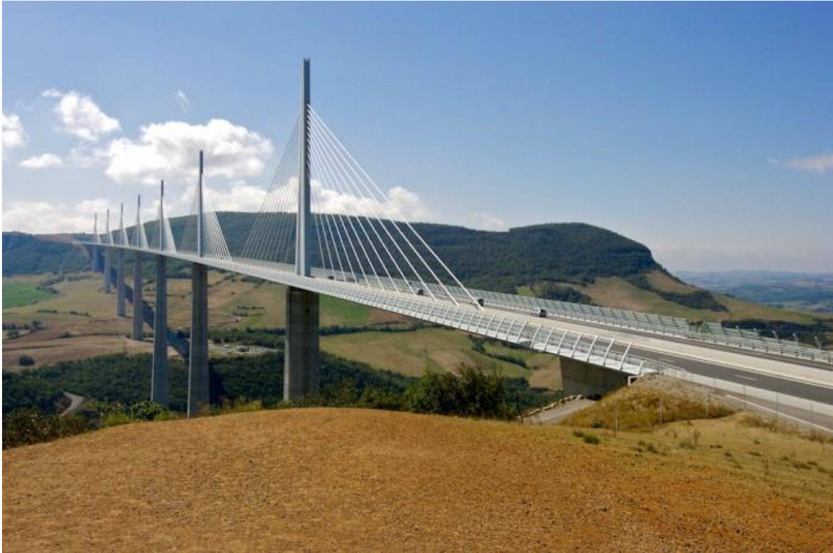
Viaduc de Millau
