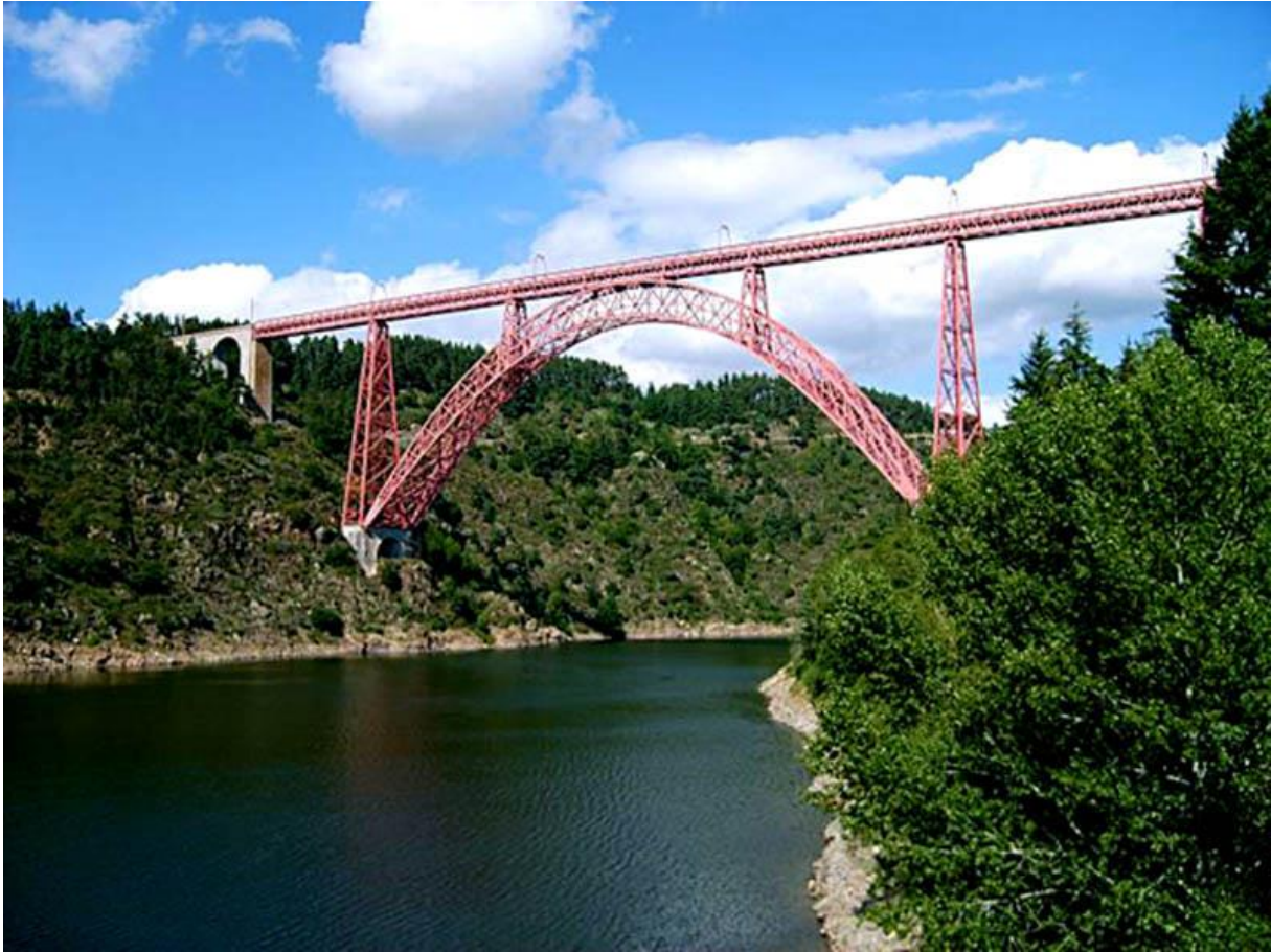
Viaduc de Garabit
